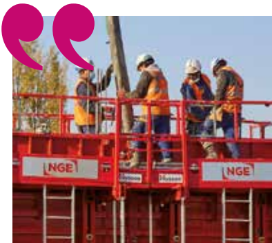
FRANCK CABRIT , Directeur de travaux, NGE
